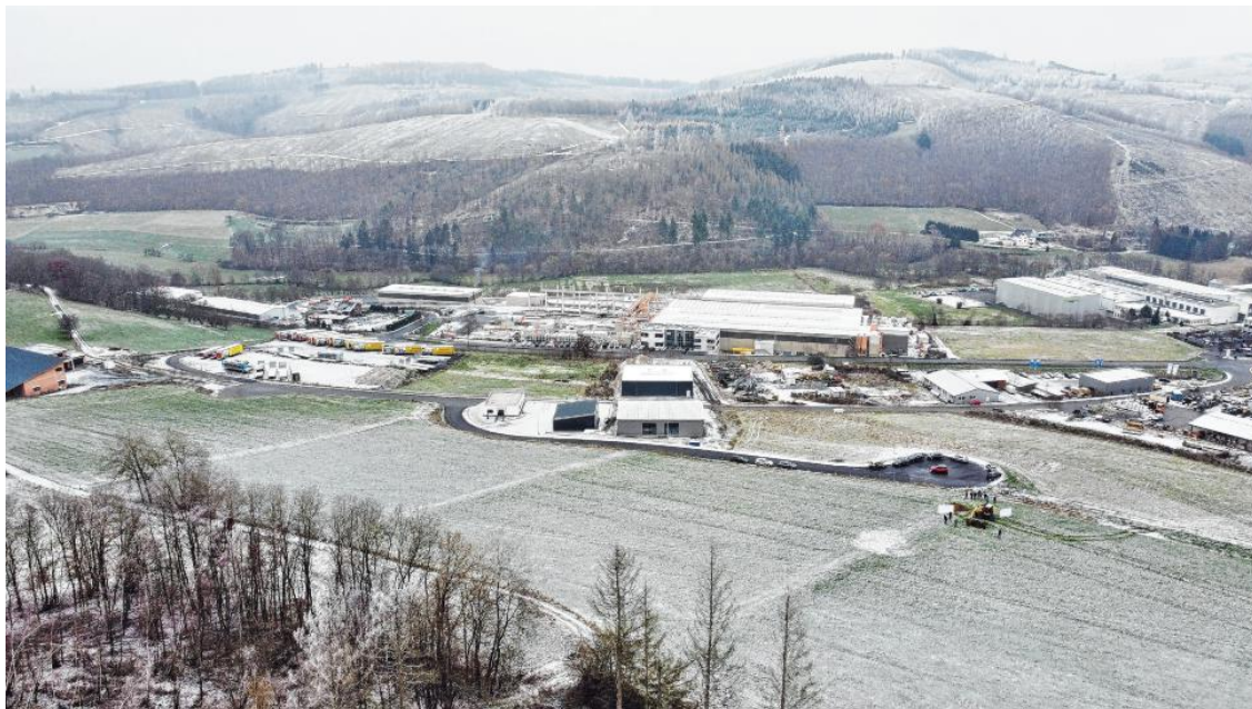
Im Gewerbegebiet In der Dell in Hegersdorf soll in den kommenden 12 Monaten eine 160 Meter lange Produktionshalle entstehen.
