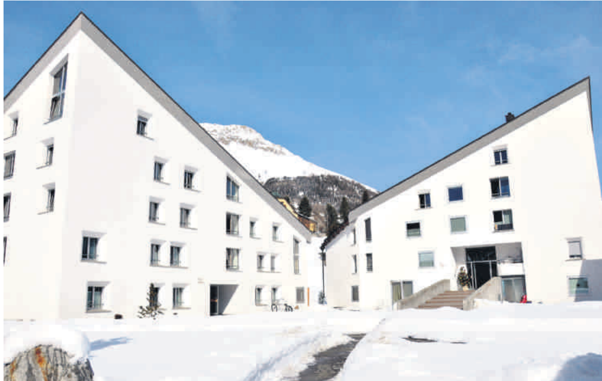
Blick auf die zwei markanten Hauptbauten des Wohnquartiers Suot Crasta, das aus einem viel beachteten Wettbewerb hervorging.
