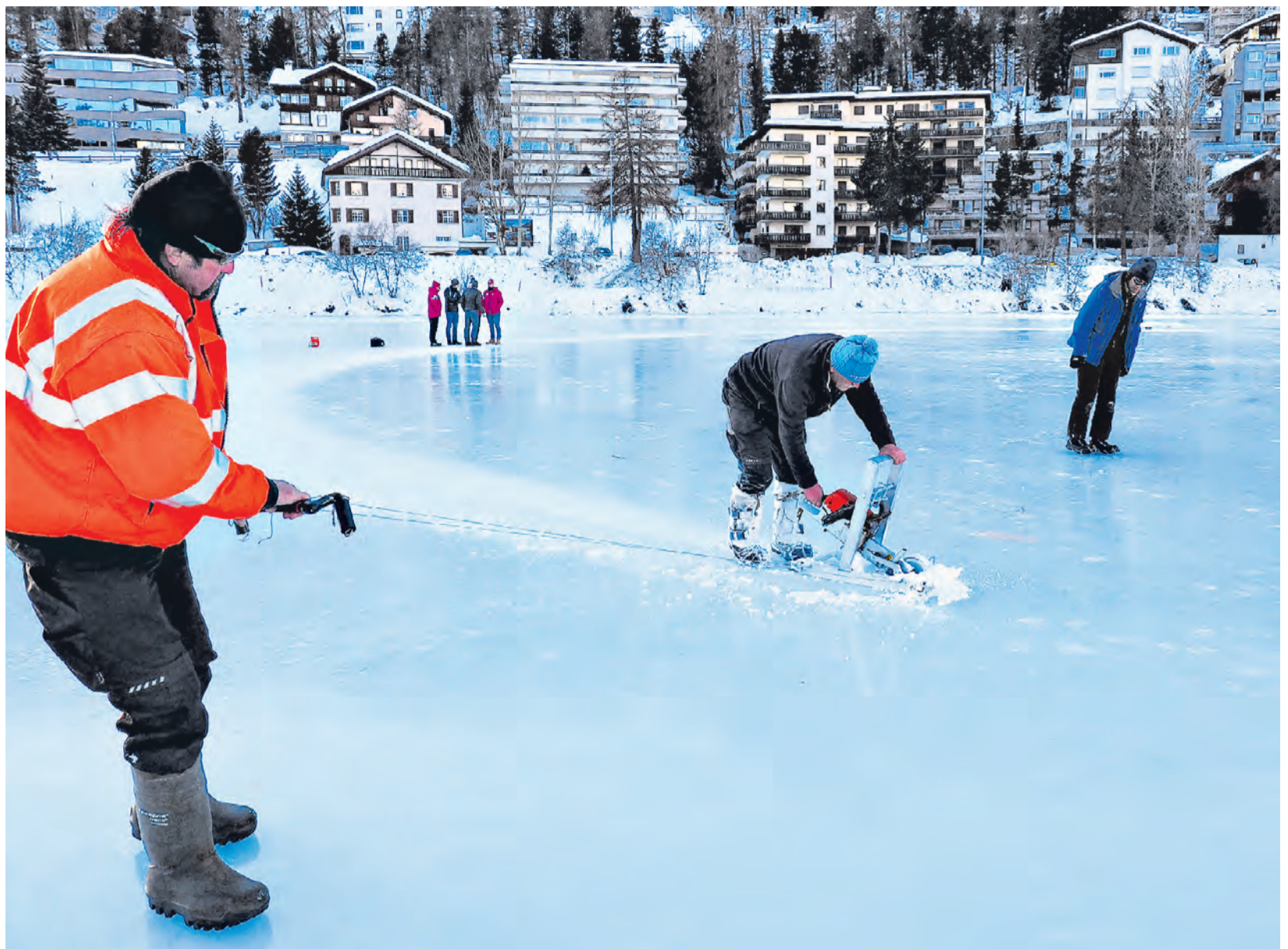
Arbeit an der Eislaufrennbahn: Louis Schönbächler (in der Mitte) fräst mit seinen beiden Helfern im Kurvenbereich zentimetertiefe Rillen ins Eis des St. Moritzersees.
