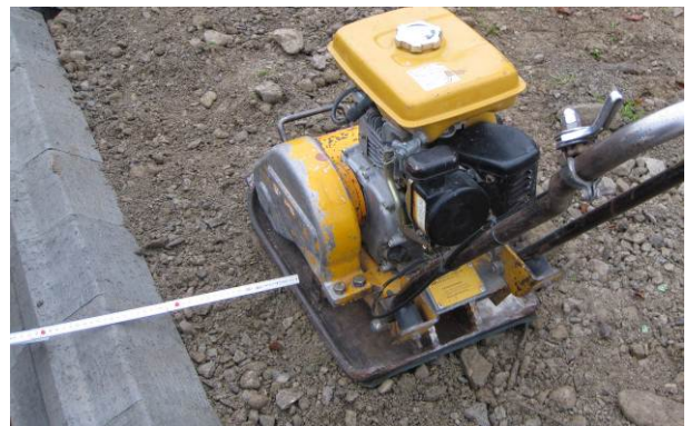
Bild 29: Verdichtung nur mit leichten Geräten
