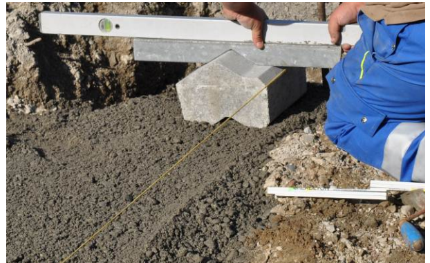
Bild 24: Benutzen einer Schablone als Hilfsmittel
