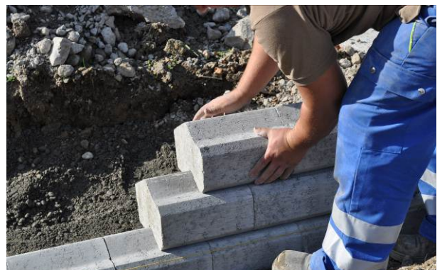
Bild 26: Versetzen der weiteren Lagen
