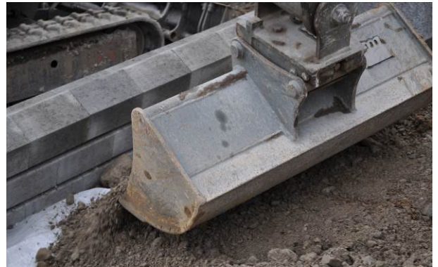
Bild 28: Lagenweises Einbringen von wasserdurchlässigen Hinterfüllmaterial
