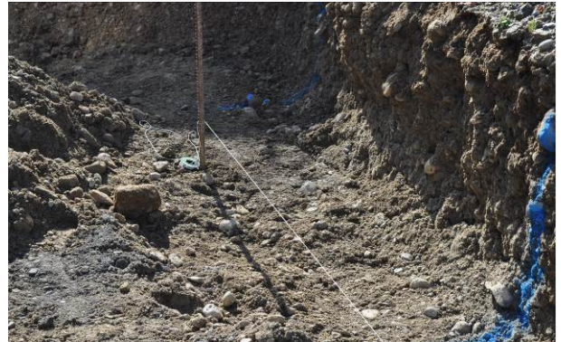
Bild 19: Abstecken der Achse
