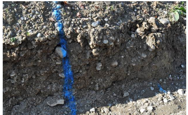
Bild 20: Aushub auf Frosttiefe
