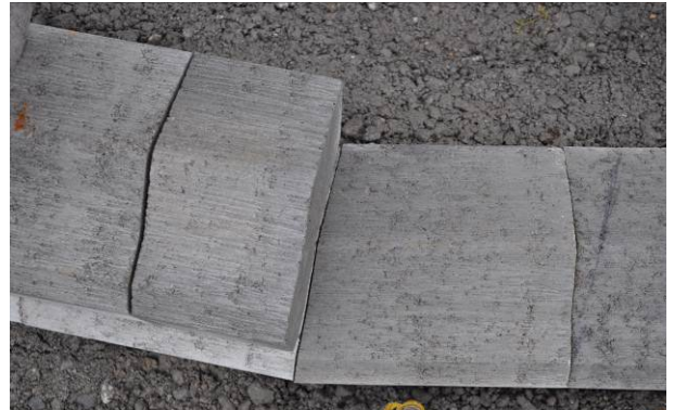
Bild 27: Zugeschnittene Pass- oder Endstücke
