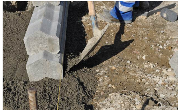
Bild 25: Erstellen des Fundamentnockens
