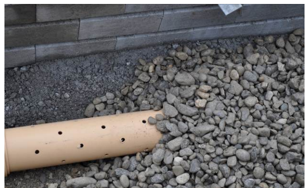
Bild 22: Einbau einer Sickerleitung
