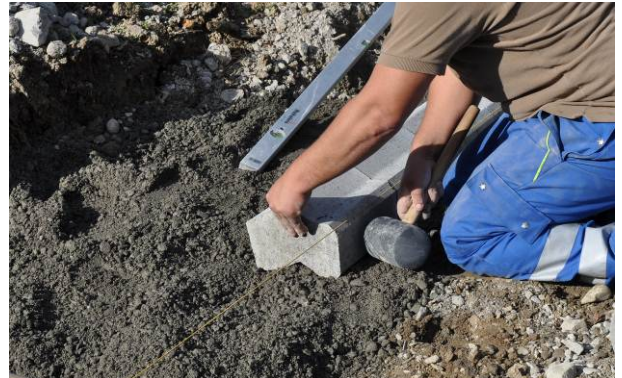
Bild 23: Versetzen der ersten Steinlage
