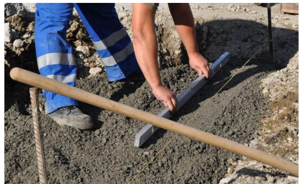
Bild 21: Erstellen eines Streifenfundamentes
