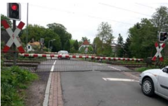
Vor dem Umbau: lange Wartezeiten an Bahnschranken
