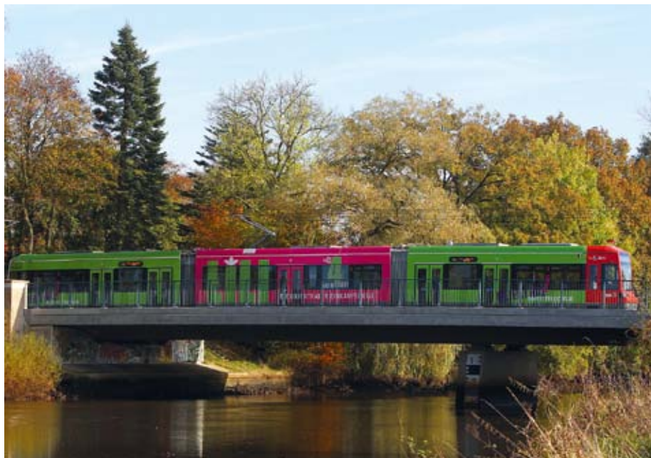
Die neue Brücke über die Wümmeniederung
