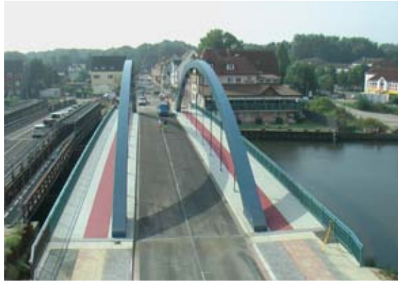
Aufteilung der Brücke: Fahrbahn mit separaten Fuß- und Radwegen, daneben die Behelfsbrücke während der Bauphase
