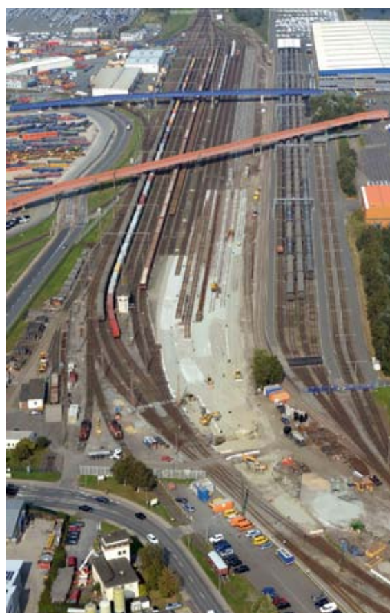
Luftaufnahme der neugebauten Vorstellgruppe im Bahnhofsteil Imsumer Deich
