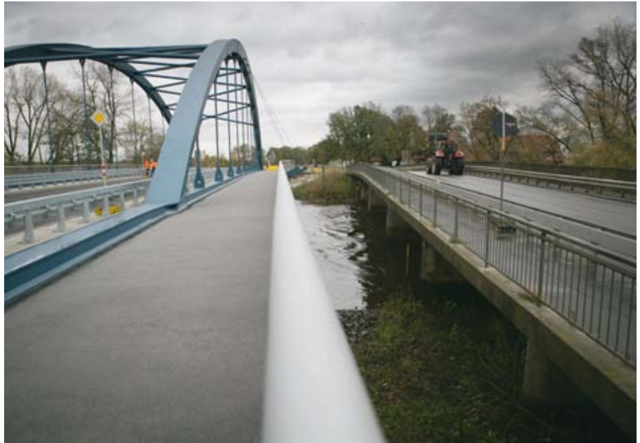
Bauarbeiten an der Wümmebrücke
