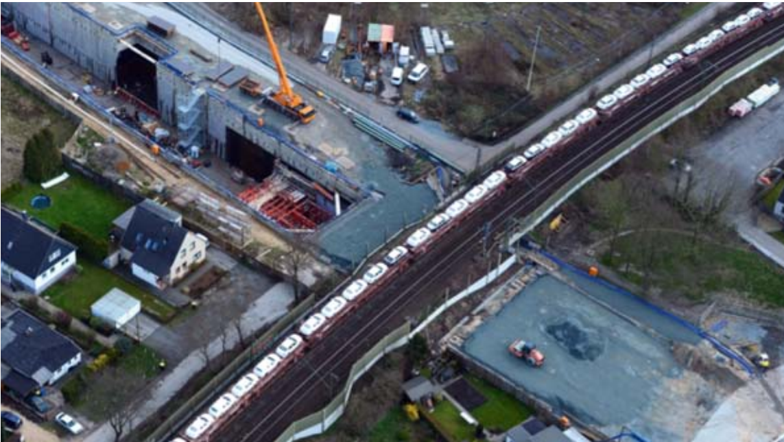
Baudock 11 im Eichenweg
