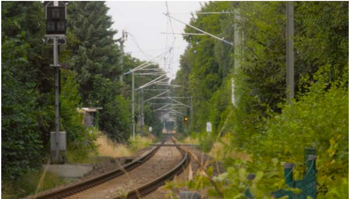
Strecke der Farge- Veogesacker Eisen- bahn nach dem Umbau
