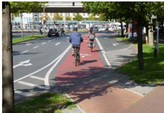
Direkte Geradeausführung auf ehemaliger Kfz-Rechtsabiegespur: Situation nach dem Umbau (oben), vorher (unten)
