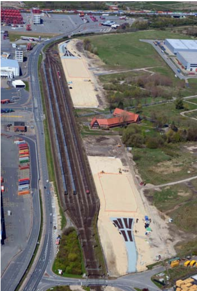
Die Hafeneisenbahn: Erhöhung der Kapazitäten bei laufendem Betrieb
