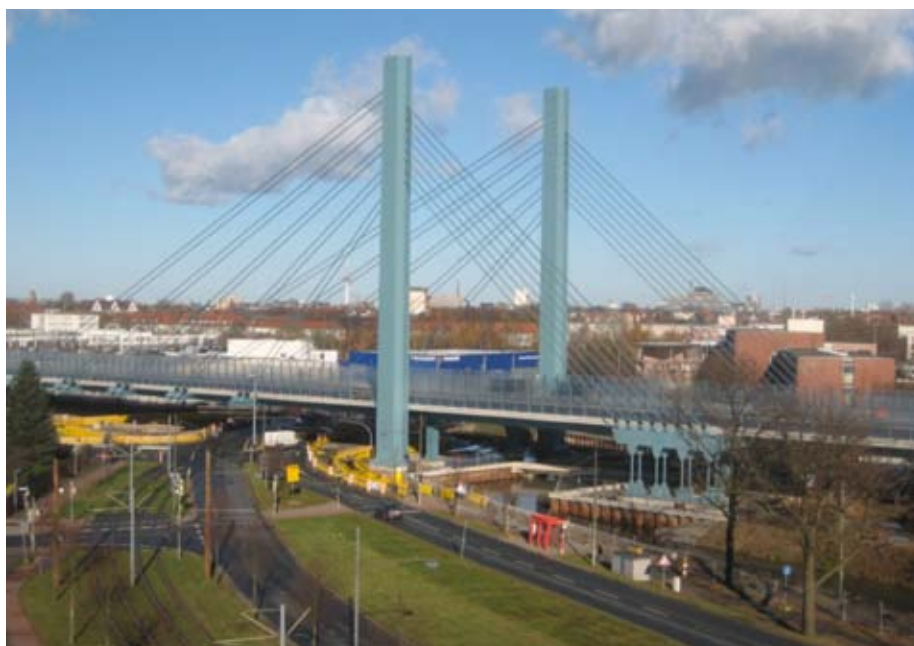
Bau der Schrägseilbrücke der A281 am Flughafendamm
