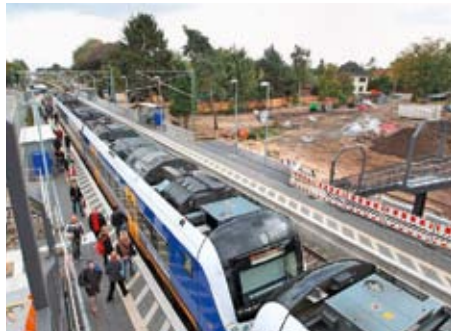
Bahnhof Mahndorf während der Umbauphase und bei der Eröffnungsfeier
