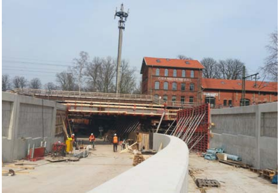
Bau der Unterführung der Franz-Schütte-Allee
