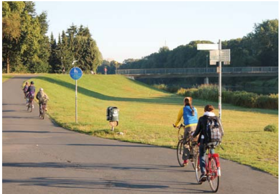
Brücke über die Kleine Weser am Werdersee, einem beliebten Naherholungsgebiet
