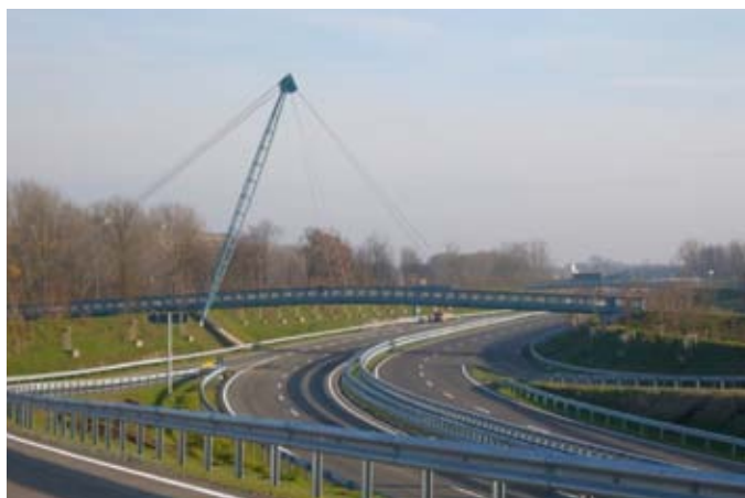
Seilverspannte Fußgängerbrücke im BA 3/1
