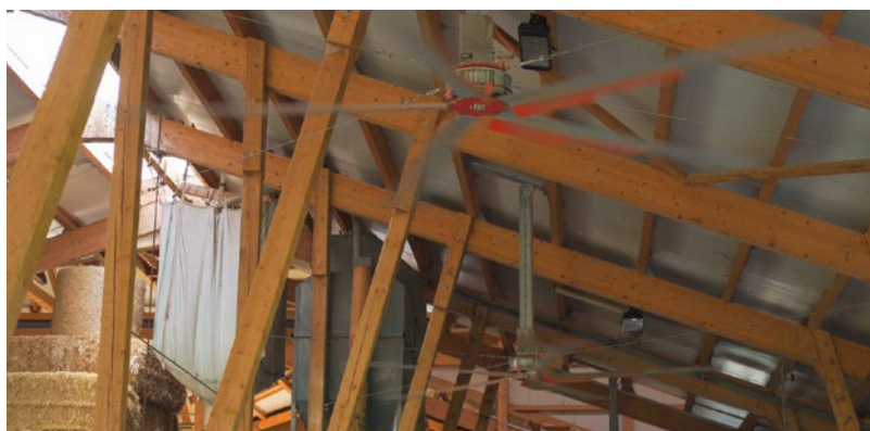
Ein Deckenventilator bewirkt eine hohe Luftumwälzung.
