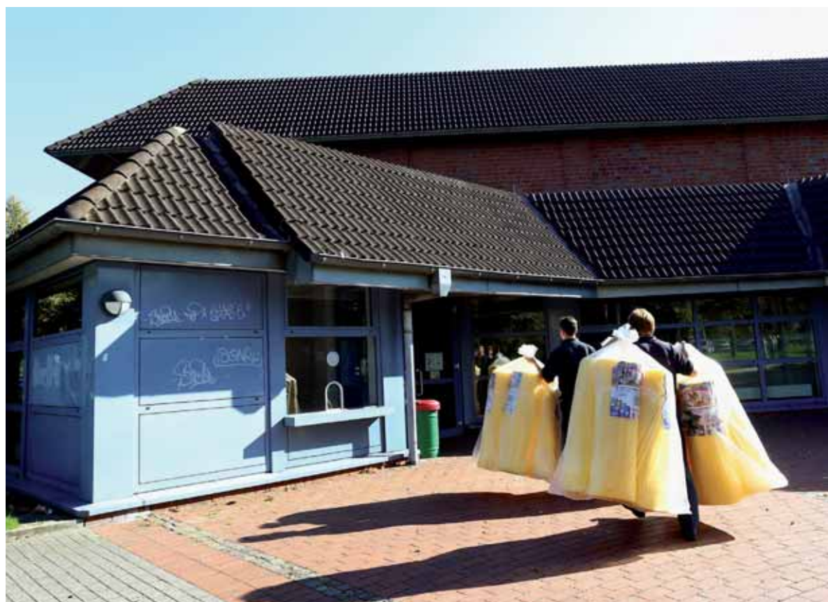
Vorbereitungsmaßnahmen: Feuerwehrleute haben die Sporthalle in Kupferdreh zur Notunterkunft umfunktioniert.
