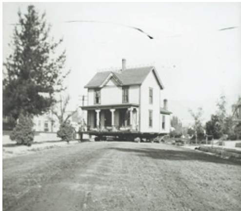
4 Aby Warburg: Transport eines viktorianischen Holzhauses auf Rollen, Pasadena, 1896
