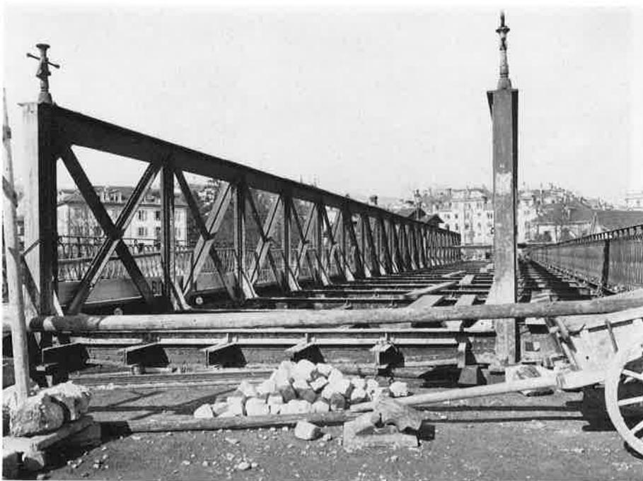
Die Langensandbrücke nach ihrer Außerbetriebnahme im Jahre 1939. Während des Baues der neuen Betonbrücke, diente die alte Eisenkonstruktion als Hilfsgerüst für den Neubau. (Photo SBB)
