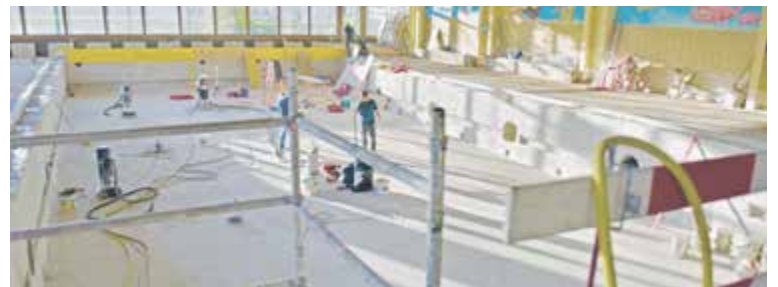
Die Arbeiten am grossen Schwimmbecken sind noch in vollem Gang. (rh)
