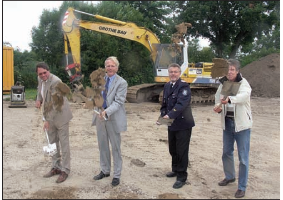
Bauarbeiterqualitäten ließen Bürgermeister Klaus Winter, Landrat Reinhard Sager, Kreiswehrführer Ralf Thomsen und der ausführende Ingenieur Jörg Konrad beim ersten Spatenstich nicht vermissen.
