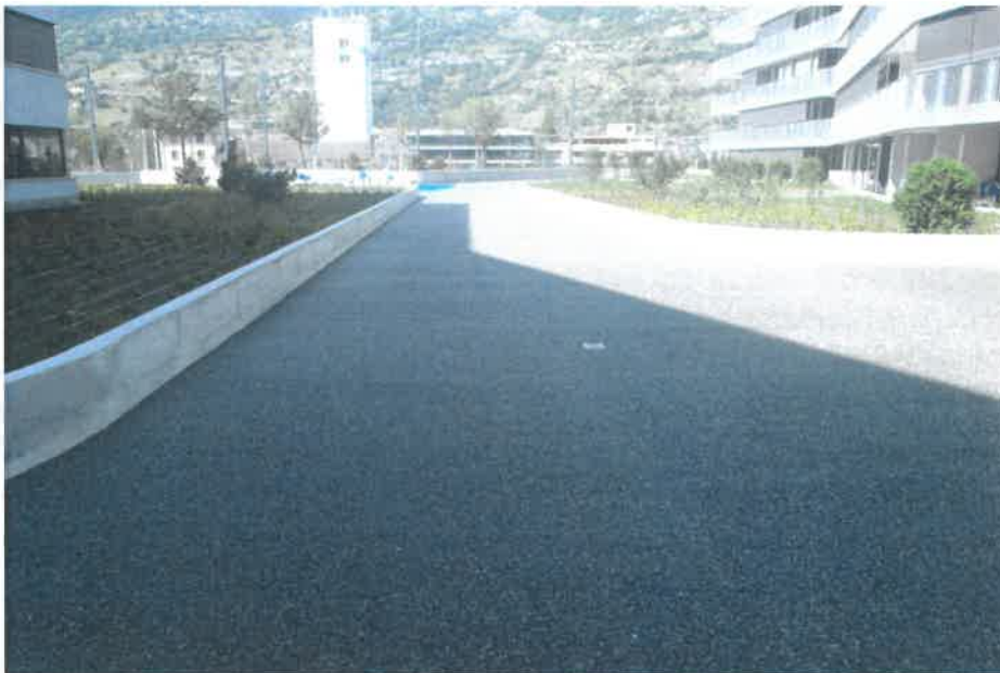
Fig. 3 – Esempio fondo in ghiaia stabilizzata
