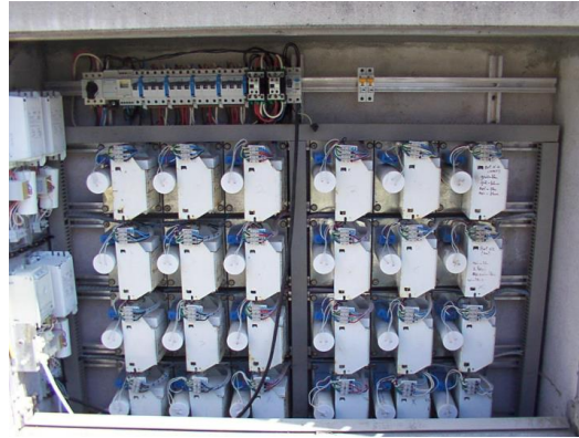
Serre des plantes mères : 24 lampes sodium 600W nécessitent 24 ballasts et électronique de consort, le tout réalisé avec soin et sécurité dans un châssis béton d'extérieur.
