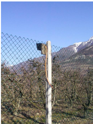
Photo de gauche : voici une alarme presque achevée. Photo de droite : une vue en profondeur vous donne une idée de la longueur à couvrir. Et encore, on n'est ici qu'à la moitié de celle-ci ! Il fallait que j'enterre les poteaux en ciment de plus d'un mètre pour rendre impossible leur arrachement à la main.
