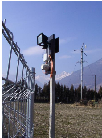
Ici, on voit bien l'ensemble de l'alarme proprement dite : Une lampe halogène de 500w avec détecteur infrarouge et une sirène branchée sur la sortie du détecteur en parallèle à la l'ampoule. Photo de gauche, la sirène est derrière l'ensemble, invisible dans cette vue. Photo de droite : le même ensemble avec la sirène. Fils et boîtiers de raccordement doivent tenir aux conditions extérieurs (hivers - été).
