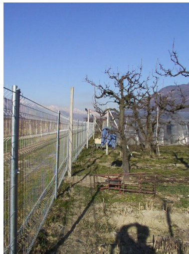
Photo de gauche : voici une alarme presque achevée. Photo de droite : une vue en profondeur vous donne une idée de la longueur à couvrir. Et encore, on n'est ici qu'à la moitié de celle-ci ! Il fallait que j'enterre les poteaux en ciment de plus d'un mètre pour rendre impossible leur arrachement à la main.
