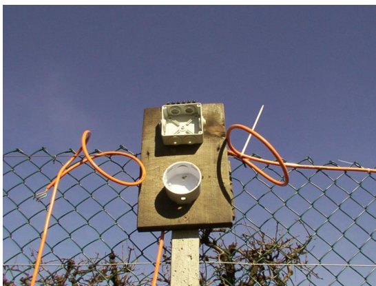
Ici, on observe les différentes phases du raccordement. En haut d'un poteau de 4 mètre, cela mettait mes systèmes hors d'état d'être sabotés. Comme j'intervenais de suite, ils n'en avaient pas le temps.
