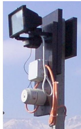
Photo de gauche : voici une alarme presque achevée. Photo de droite : une vue en profondeur vous donne une idée de la longueur à couvrir. Et encore, on n'est ici qu'à la moitié de celle-ci ! Il fallait que j'enterre les poteaux en ciment de plus d'un mètre pour rendre impossible leur arrachement à la main.
