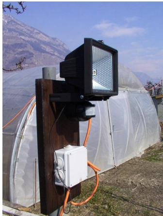
Ici, on voit bien l'ensemble de l'alarme proprement dite : Une lampe halogène de 500w avec détecteur infrarouge et une sirène branchée sur la sortie du détecteur en parallèle à la l'ampoule. Photo de gauche, la sirène est derrière l'ensemble, invisible dans cette vue. Photo de droite : le même ensemble avec la sirène. Fils et boîtiers de raccordement doivent tenir aux conditions extérieurs (hivers - été).
