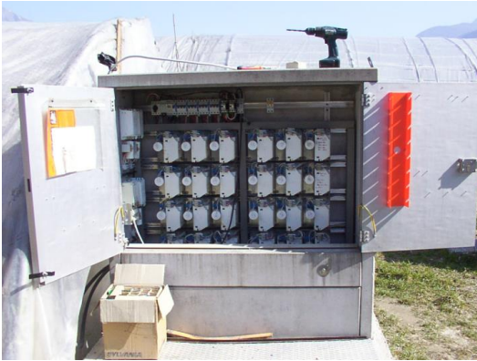
Serre des plantes mères : 24 lampes sodium 600W nécessitent 24 ballasts et électronique de consort, le tout réalisé avec soin et sécurité dans un châssis béton d'extérieur.
