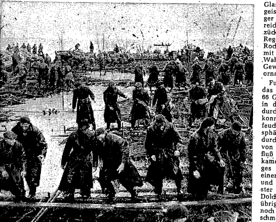
Noch immer seit der Flutkatastrophe repariert - Holland die Deiche wie hier bei Scheelphouk, wo die See ein 400 m langes Stück herausgerissen hatte.
