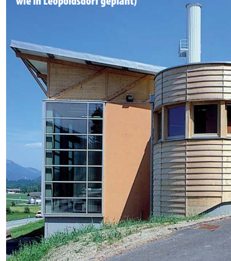
Symbolfoto Biomasse-Heizwerk Söll (mit ähnlicher Kapazitätsgröße wie in Leopoldsdorf geplant)
