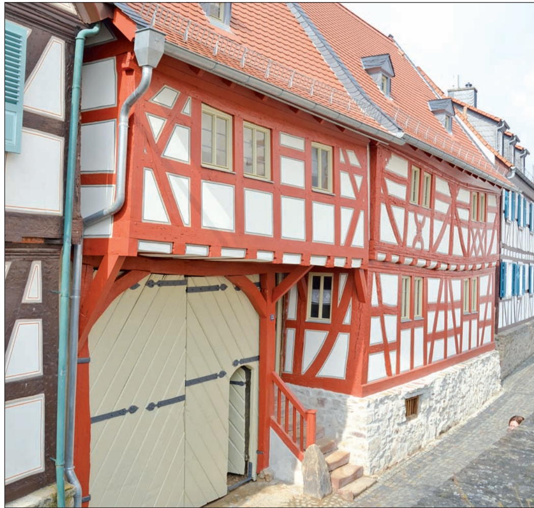
Mit rotem Fachwerk präsentiert sich die vorbildlich und unter großem Aufwand restaurierte Fassade des Anwesens Sankt-Ursula-Gasse 13 von Jörg Steden. Fotos: Bachfischer
