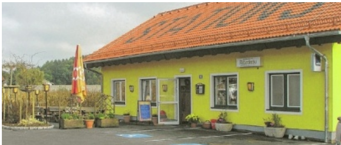
Die neue „Station 5“ wurde in der Rekordzeit von drei Monaten neu errichtet.
