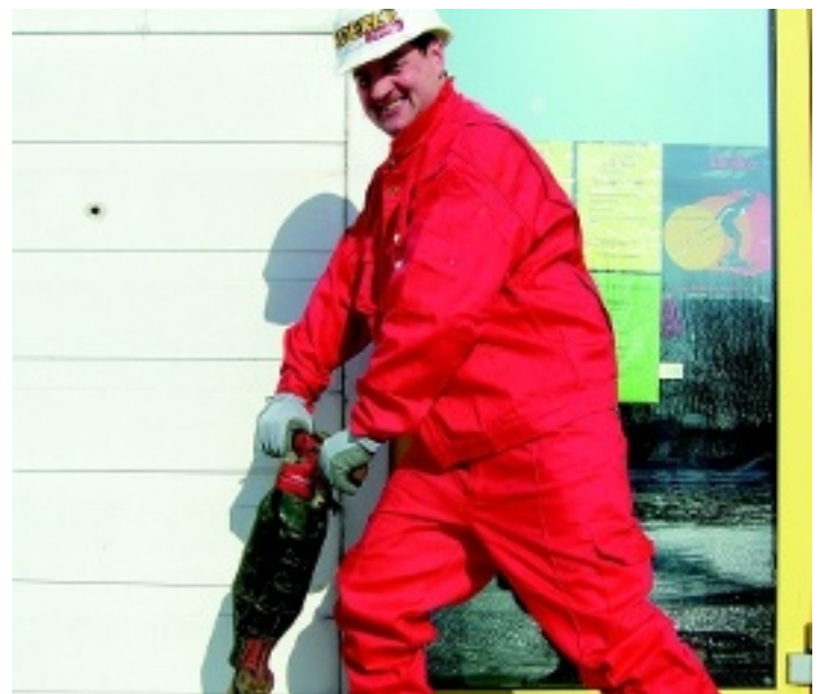
Andreas Haderer legt selbst Hand an mit dem Presslufthammer für den Umbau.
