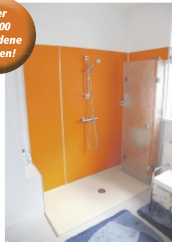
Nachher: Barrierefreie, rutschfeste, fugenlose Dusche mit wegfaltbarer Duschtrennwand – pflegeleicht!
