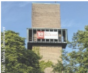
Der markante Turm der Perner Kirche
