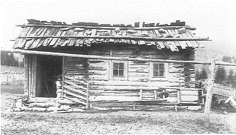
Abb. 8: Dokumentar-Photographie Wohnhaus eines armen Huzulen W. Szuchiewicz, 1902, Widmung (Inv.-Nr. 754)
